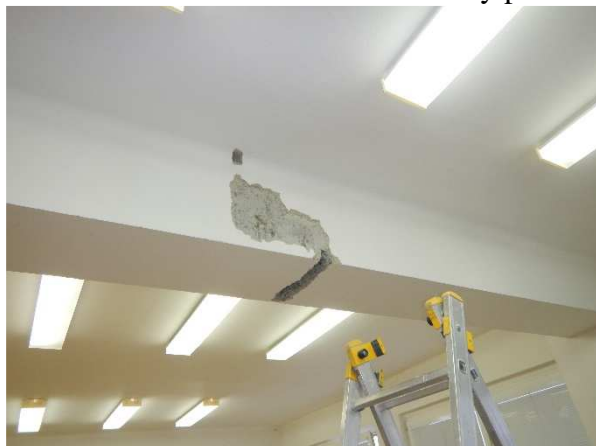
Foto č. 9 a 14 – sonda NV 3 – celkový pohled a detail sondy
