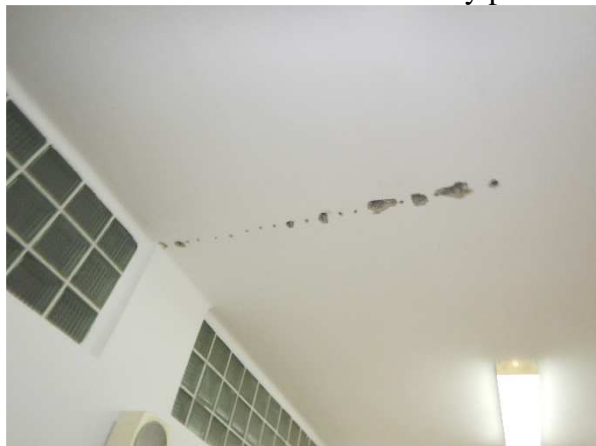
Foto č. 1 a 4 – sonda NV 1 – celkový pohled a detail sondy
